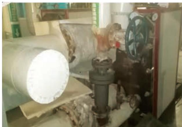
公司总部六层景观水池未安装纳米合金防垢器前，每15-30天需用化学药剂除垢一次，每次防水，冲洗用水约20吨。2019年11月安装并使用了一台纳米合金防垢器，使用至今，景观水池仍未曾进行过任何清洗或换水，只有少量补水。除垢、抑制苔藓功能明显。
