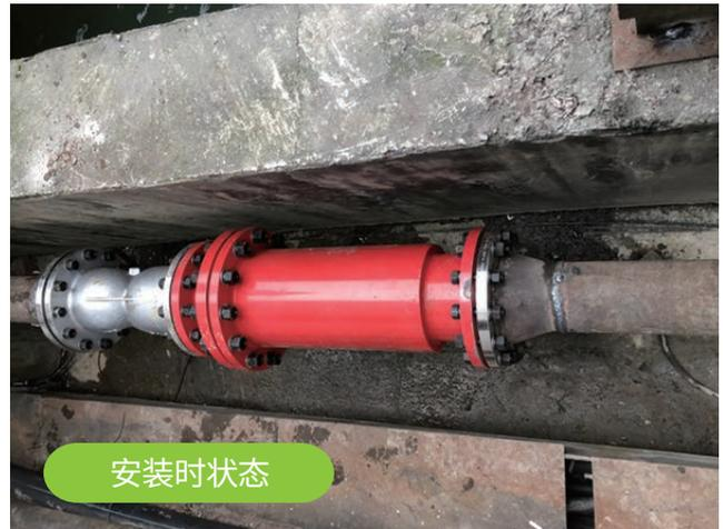
重庆市博赛矿业（集团）有限公司阿坝铝厂冷冻式干燥机循环水系统，自2018年11月7日安装了纳米合金防垢器到2019年5月8日打开查验效果，冷冻干燥机结垢的严重的部位很干净没有垢，此有照片前后对比图，效果一目了然。纳米合金防垢器防垢除垢效果很明显。
