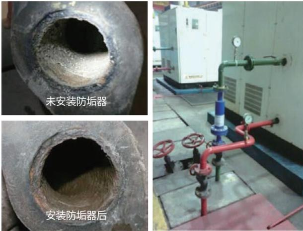
济三煤矿是兖矿集团的下属单位，空压机站的空压机系统冷却用水，原来一直使用井水加药剂防垢处理；添加药剂需要专门人员进行添加，即便加药处理空压机内部系统仍然结垢，冷却效果始终不理想，因此每年必须定期对空压机管线，泵管线进行酸洗处理，加大了成本的投入，还影响了正常的生产。2019年安装了一套纳米合金防垢器之后，停止加药空压机运转正常，工作至今仅拆开冲洗过一次，结垢现象极大缓解。
