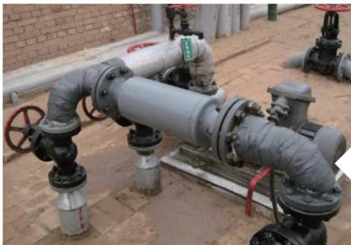
某油田采油二厂元东三转输油泵，由于结垢严重，在不加防垢剂的情况下，15天就需要拆泵进行清垢，随后采取加化学防垢剂的办**法**，稍有缓解，但费用较高。
